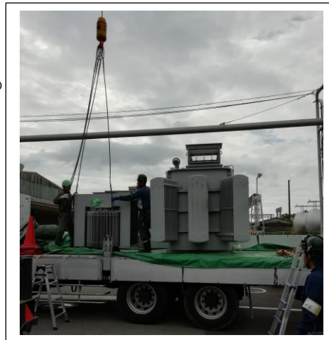
トランスの搬出処理
