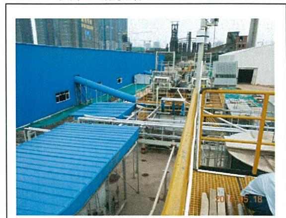
水処理装置と脱水機
