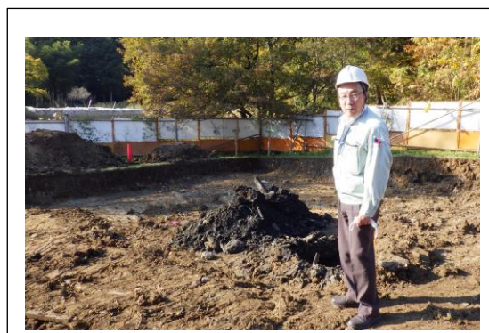
埋設産廃の除去工事
