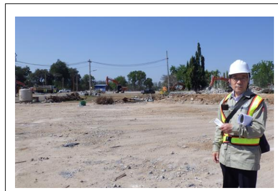
タイの製糖工場解体工事
